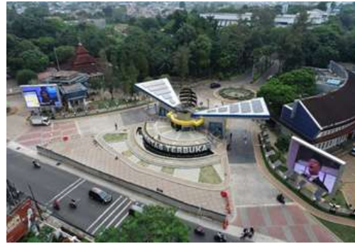
Pembangunan Gerbang baru UT Pusat
