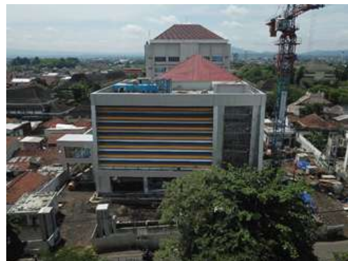
Pembangunan UT Purwokerto
